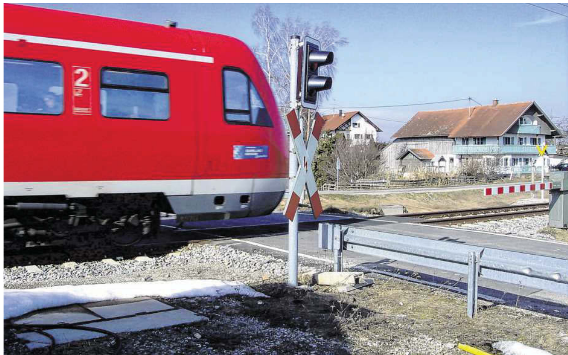
Der Bahnübergang „Grabus“ in Sontheim ist bald Geschichte. Er wird durch eine Überführung ersetzt.
