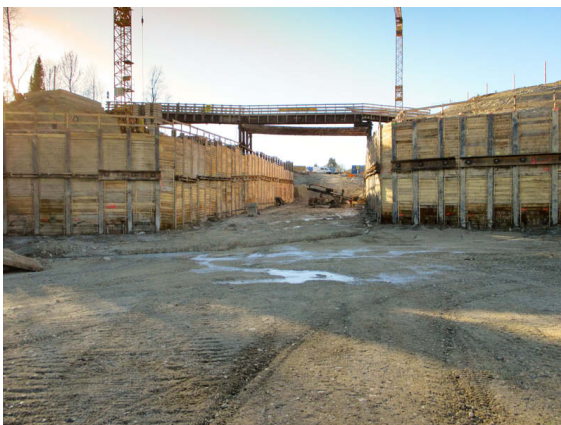
Verbau und Behelfsbrücke im Hintergrund
